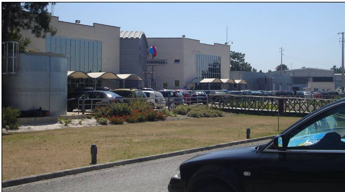
Fotografia 3.10.4 – Instalações da Cabo Visão, entre o Apoio P21 e P22, a 120 m da Linha
