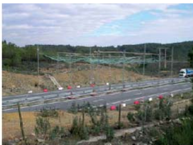
Figura 4.11.1 – Aspecto de Estrutura Porticada para a Protecção das Vias Sobrepassadas pela Linha
