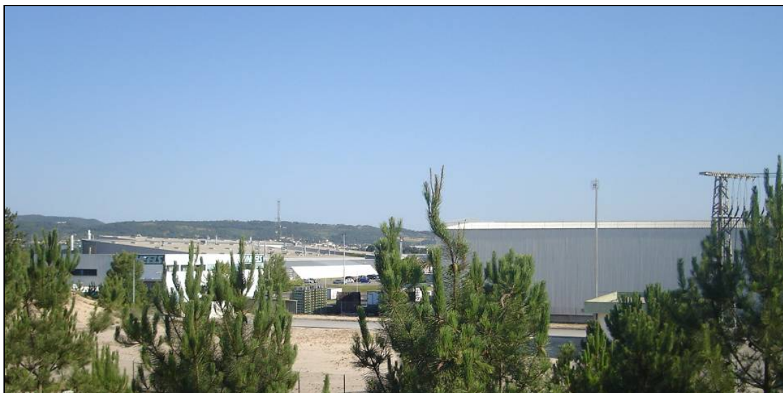
Fotografia 3.10.6 – Panorama geral do Parque Industrial da Autoeuropa, entre o Apoio P46 a 37, a 270 m da LMAT em estudo
